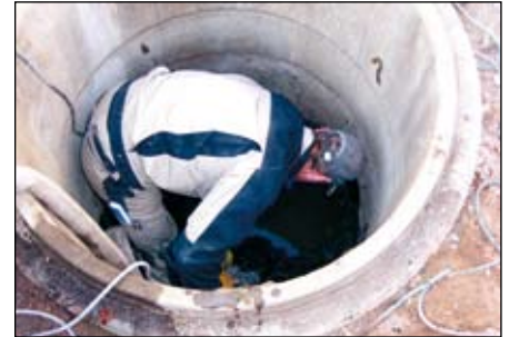
2.) Steigstufen entfernen, Berme und Gerinne abstemmen, Wasserhaltung, Überpumpbetrieb einrichten
