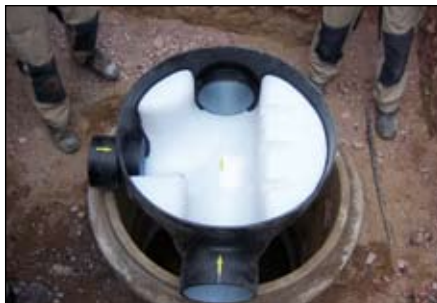
4.) Vorgefertigtes Gerinne mit PE-Stützen anpassen
