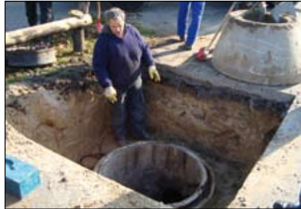
1.) Asphalt aufschneiden, Betonkonus abheben
