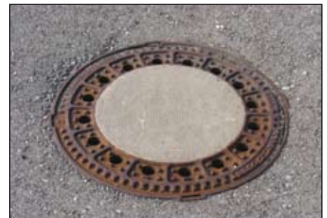
11.) Wiederherstellen des Straßenaufbaus und der Straßenoberfläche incl. lastentkoppelter Abdeckung
