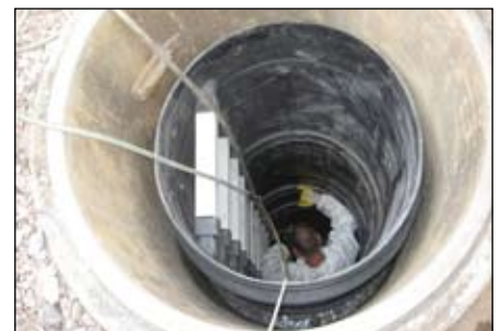
8.) Aufsetzen der Dichtungen und Schachtbauteile – PE Schachtsystem DN 800
