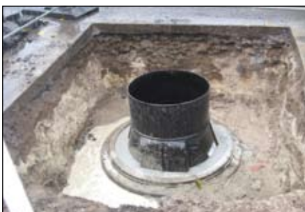
9.) Verfüllen des Zwischenraums zwischen PE-Schacht DN 800 und Betonschacht DN 1000 mit Verfüllmörtel
