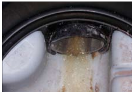
7.) Nach Aushärten des Verfüllmörtels kann die Wasserhaltung abgebaut werden
