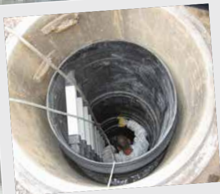
Lösung 2 Schacht-in-Schacht-Sanierung
