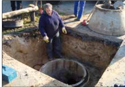
1.) Asphalt aufschneiden, Betonkonus abheben
