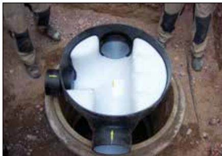
4.) Vorgefertigtes Gerinne mit PE-Stützen anpassen
