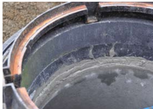
Evtl. weitere Ausgleichsringe aufsetzen (bei dichter Verbindung Soudaseal 235 SF verwenden). Abdeckung aufsetzen.
