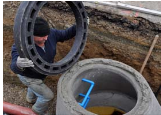
Passenden Ausgleichsring auswählen und aufsetzen
