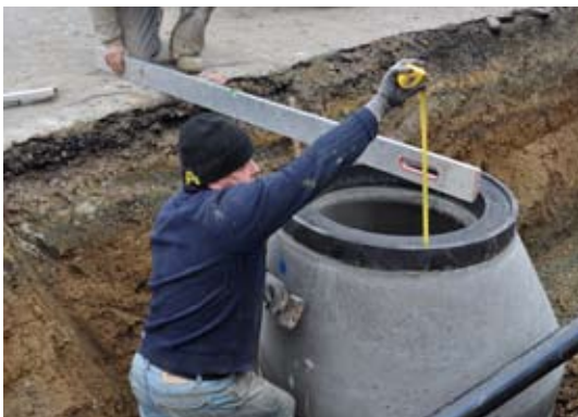
Ausgleichsring ausrichten
