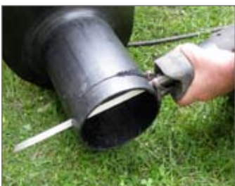
PE-Stützen anpassen
