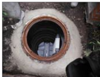
Schacht fertig saniert
