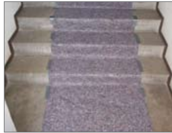
Zugang nur durch das Treppenhaus
