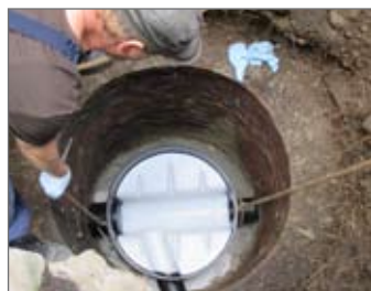
neuen Boden in den Schacht ablassen
