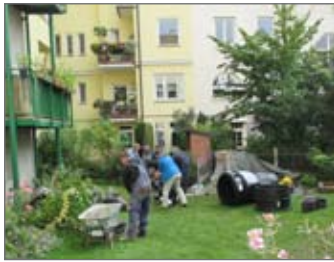
Schacht im Innenhof, keine „große“ Baustelle möglich
