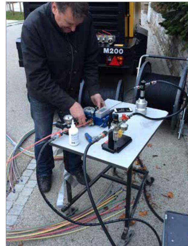
Glasfaser-Kabel werden eingeblasen.
