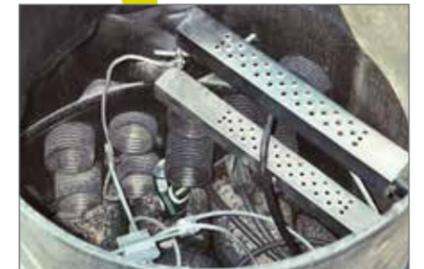
Steigstufen sind bei Bedarf (Kabeleinbau) leicht zu entfernen.
