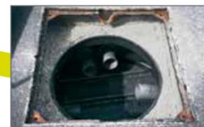
Dichtes Schachtabdeckungssystem mit getrennter Dicht- und Tragfunktion
