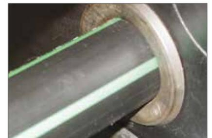
Rohranbindung mit Dichtung 0,5 bar wasserdicht
