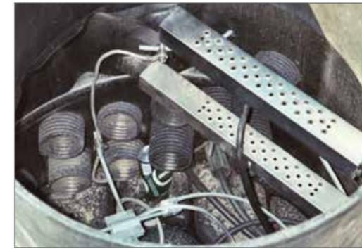
Steigstufen sind bei Bedarf (Kabeleinbau) zu entfernen.
