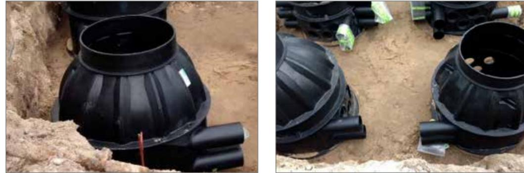
Für höchste Anforderungen: absolut dichte Ausführung durch verschweißte PE-Leerrohre
