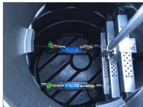
Wasserzählerschacht mit integrierten Einbaugarnituren
