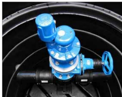
Hydrophobe Kunststoffschächte reduzieren das Korrodieren der Armaturen deutlich.
