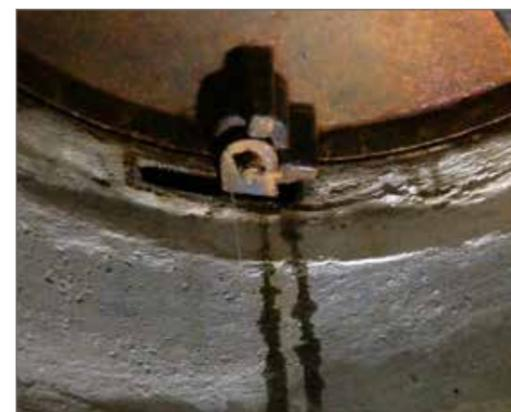
Oftmals hält eine tagwasserdichte Abdeckung nicht das, was sie verspricht. Wasser dringt am Rand der Abdeckung ein und sorgt für Wasser und Feuchtigkeit im Schacht
