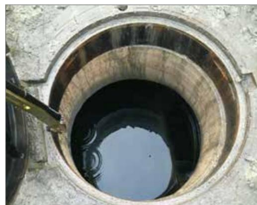
Grundwasser sorgt in vielen Fällen für die Flutung von Schachtbauwerken. Das anstehende Grundwasser sickert durch den Werkstoff bzw. läuft ins Schachtinnere durch fehlerhafte Dichtungen.
