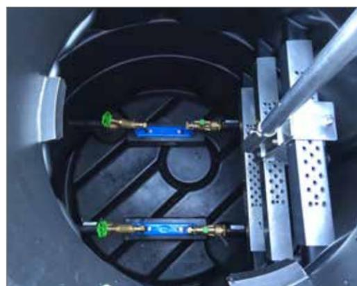
Die dreiseitige Lippendichtung (Tripple-Safety-Seal) von ROMOLD sorgt für eine 100 %ige Dichtigkeit des Schachtbauwerks.
