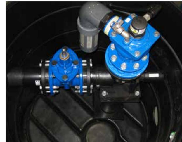
Be- und Entlüftungsschacht mit Rückstausicherung
